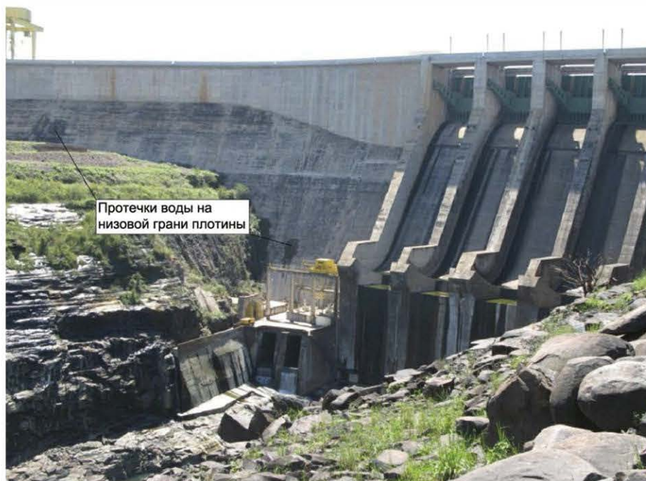
Рисунок 6.2.1 - Плотина из укатанного бетона.
