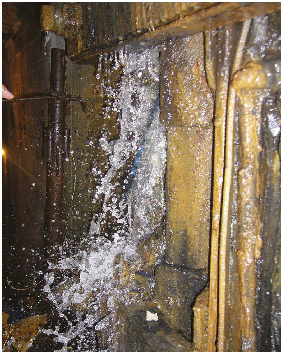
Рисунок 7.2.36 - Напорная течь.
