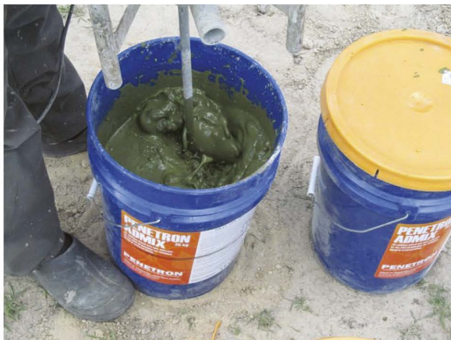
Рисунок 7.1.1 – Гидроизоляционная добавка «Пенетрон Адмикс» перед ее введением в бетонную смесь.
