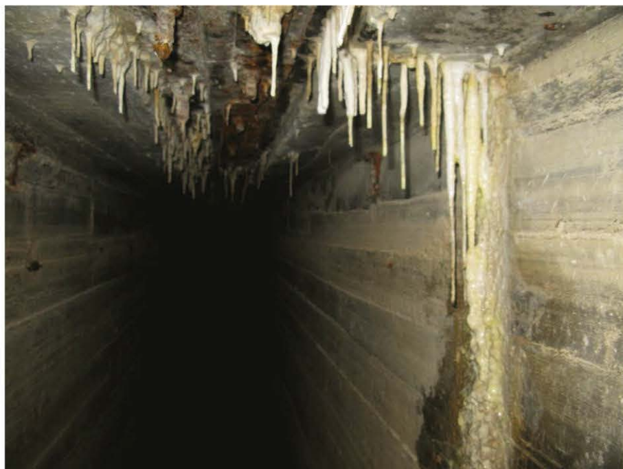
Рисунок 5.3 - Фильтрация воды с выносом гидроксида кальция через швы бетонирования и из-под потолочного уплотнения деформационного шва в соединительном коридоре между смотровыми шахтами верхнего и нижнего бьефов.
