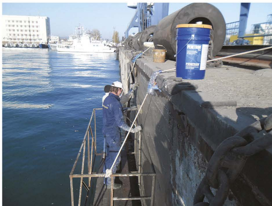
Рисунок 6.5.3 - Железобетонные причальные сооружения: а - морские причальные сооружения; б – выполнение работ по гидроизоляции причального сооружения.
