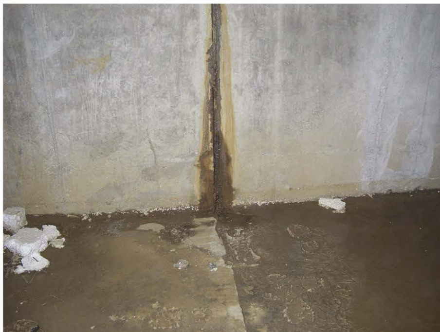
Рисунок 7.2.35 - Безнапорная течь.
