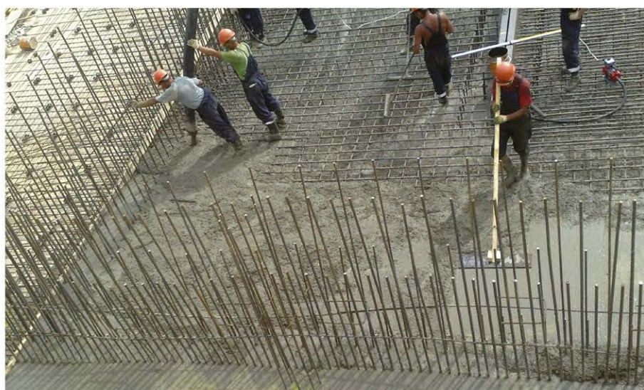
Рисунок 7.1.3 - Укладка бетонной смеси.
