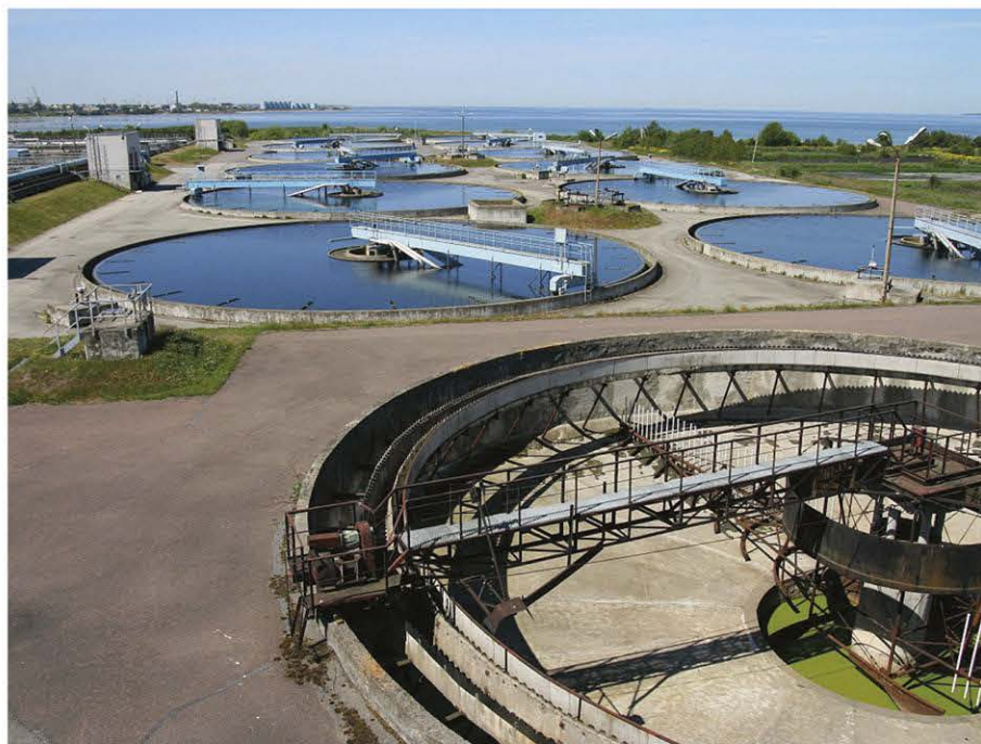
Рисунок 6.4.1 - Радиальный отстойник из монолитного железобетона.
