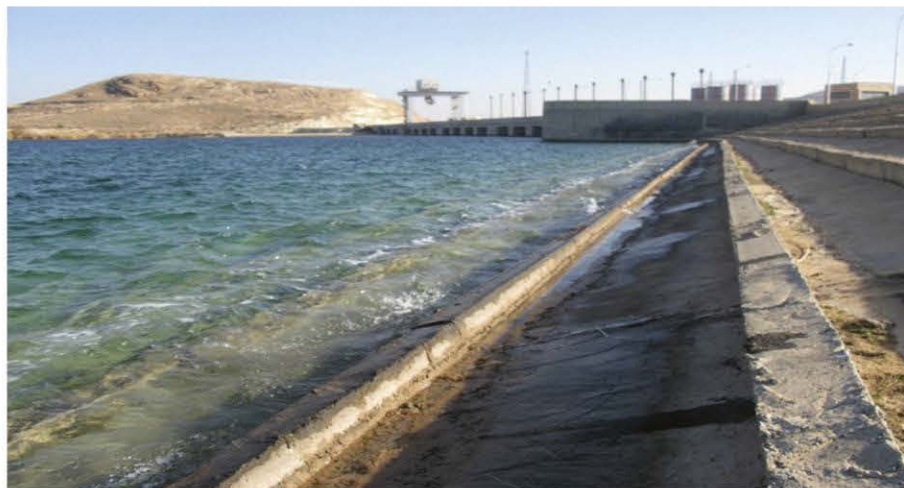
Рисунок 6.6 - Железобетонные крепления откосов грунтовых плотин:
