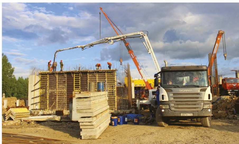
Рисунок 7.1.4 - Подача бетонной смеси в опалубку.
